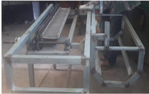
Gambar 3.20 Perakitan Ruang Pembakaran.
